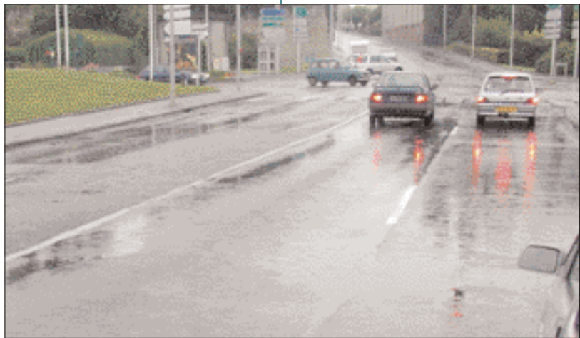
Carrefour : Demande d'adhérence forte en zone d'arrêt des véhicules.
